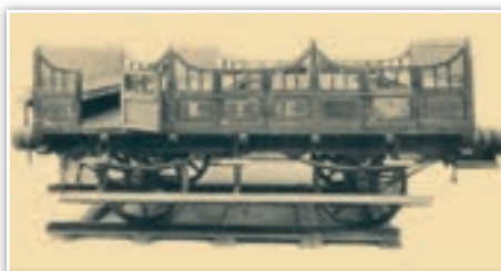
Открытый пассажирский вагон III класса железной дороги Бреслау—Фрайбург, 1843 г. Открытка. 1900—1910-е гг.
